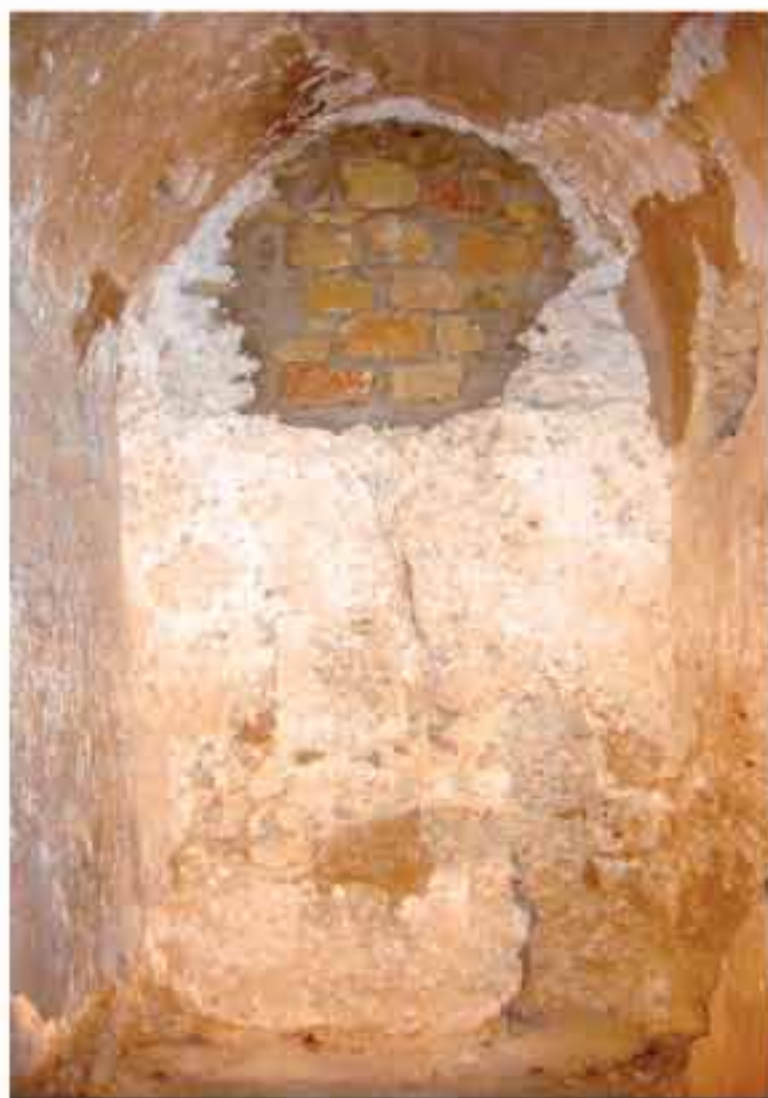
Pared norte del calabozo antes de la restauración.
